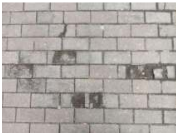
(Рисунок 1, напольная плитка, проржавевшая от Cl-)
